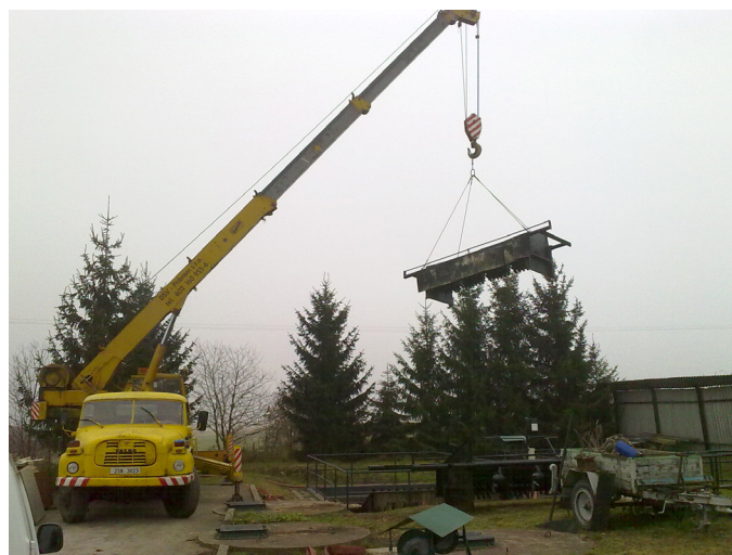
práce na ČOV
