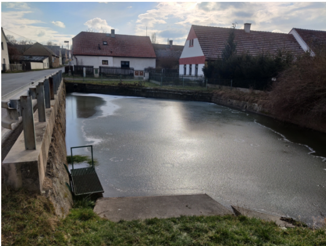
Obr. 11: Vodní nádrž v Rosovcích
