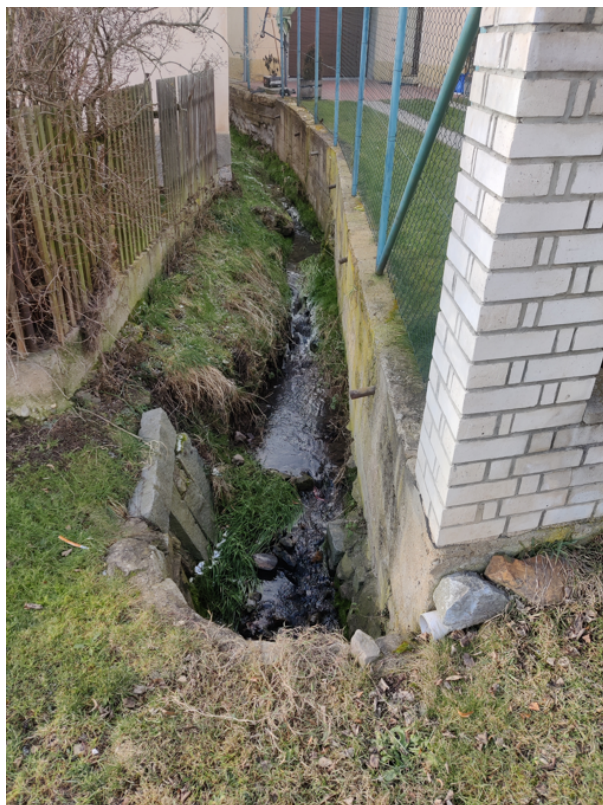
Obr. 12: Vtok do zatrubnění v Rosovcích (kritické místo)
