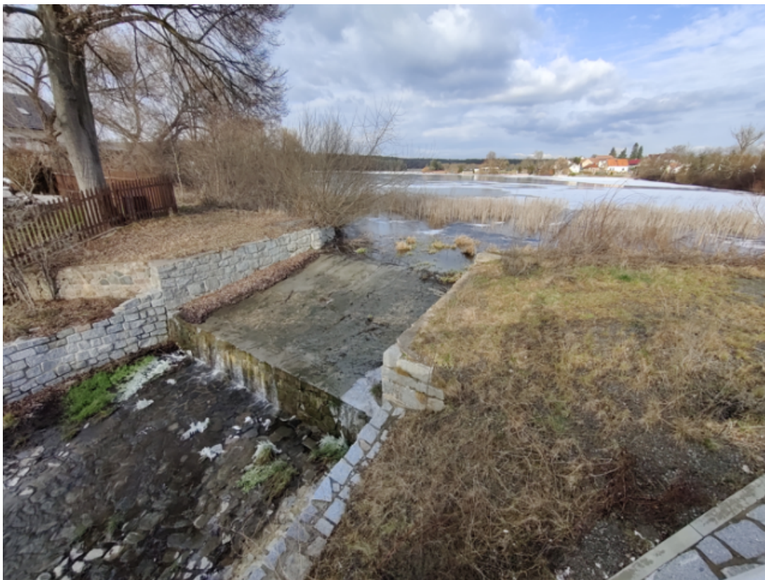
Obr. 7: Bezpečnostní přeliv na Sychrovském rybníku
